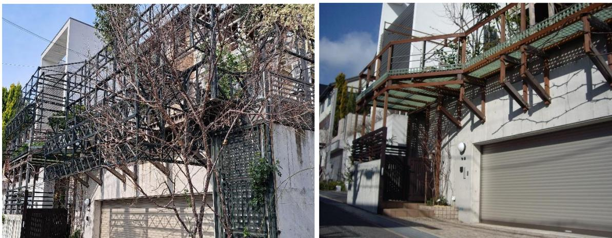
上の右の写真は、作った当初のものです。左は現在の姿です。冬ですから、ブドウなどの葉は全て落ちていますので、取り付けた柵の形がよくわかると思います。柵に使っている材木は針葉樹のものがほとんどですが、防腐剤入り塗料で保護していても、やはり、腐朽菌などが入って腐食してきます。冬の間、腐った部分を取り換えたり、塗装をし直したりと、忙しい毎日です。
